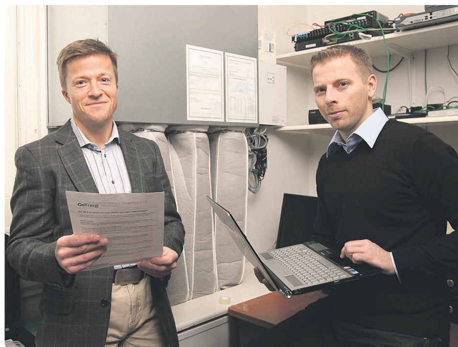
Direktør Claus Herbert og Ingeniør Johnny Bagge, i serverrummet hos ATP Ejendomme, hvor energiforbruget og CO 2 -udledningen blev reduceret med 96 %, ved at installere frikøling.
